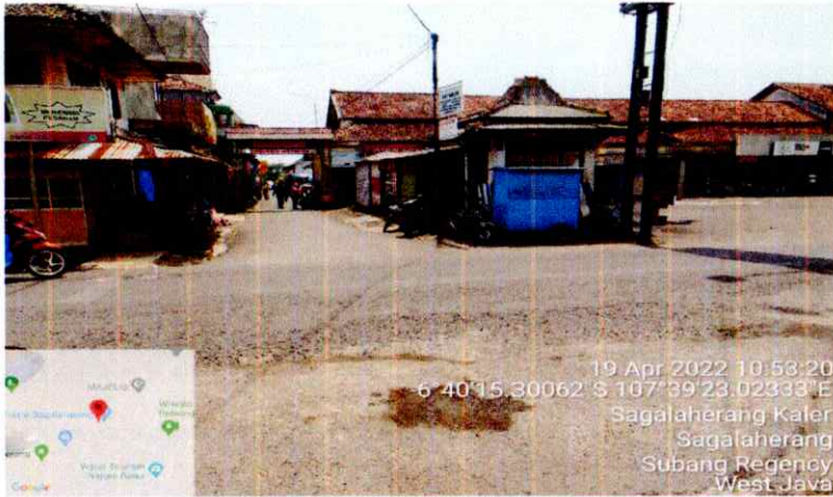
Rencana Pipa Crossing Di Desa Sagalaherang.
